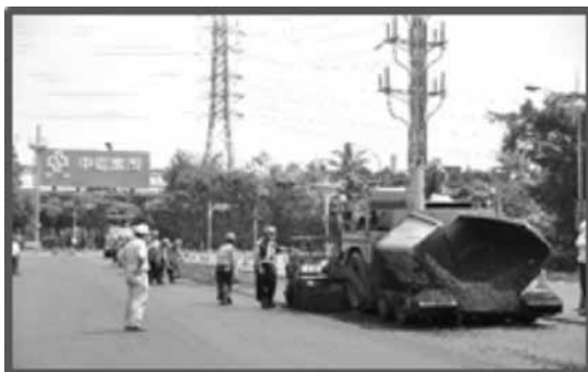
圖(3-5)高雄市區道路轉爐石AC鋪築
