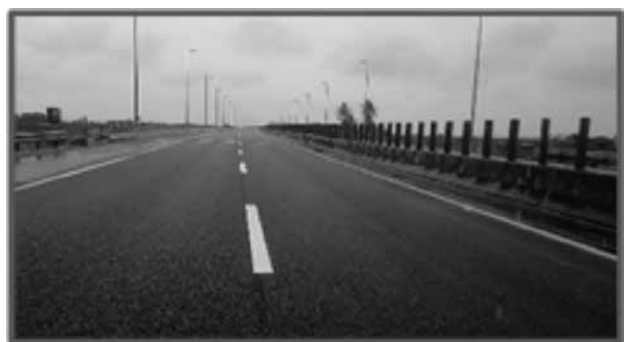
圖(3-6)高速公路轉爐石AC鋪築
