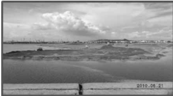
圖(3-11)轉爐石應用於南星計畫填海造陸
