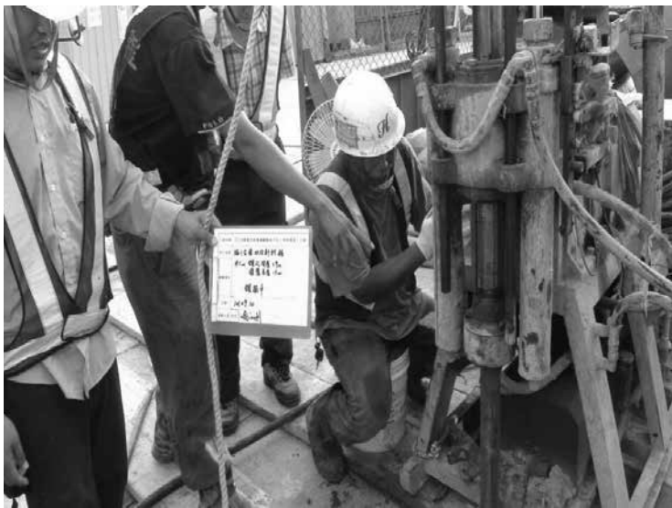
圖7.海岸旁地鐵工程進行高壓噴射灌漿工法全景
