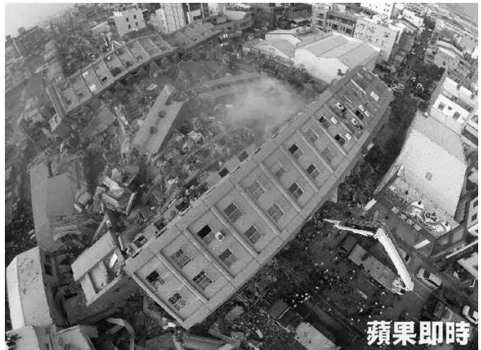
圖1. 0206美濃大地震造成台南地區房屋倒塌 [1]
