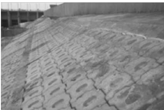
圖(3-9)轉爐石應用於台南水利局堤岸護坡塊
