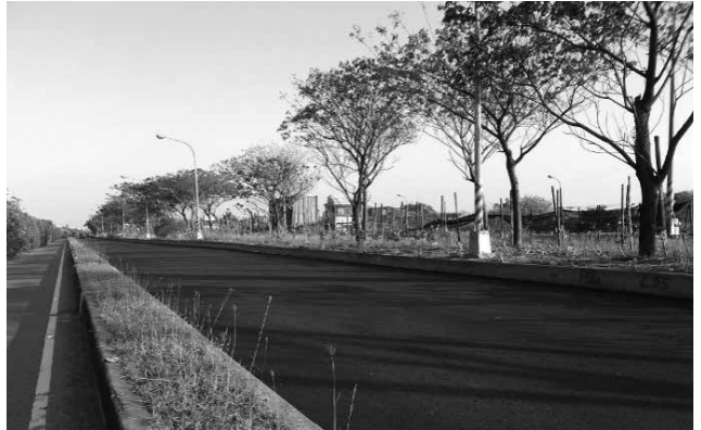
圖八 南星路以轉爐石瀝青混凝土改善後照片
