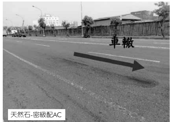
圖六 高雄市亞太路轉爐石粒料與天然粒料瀝青混凝土經過四年之使用狀況圖
