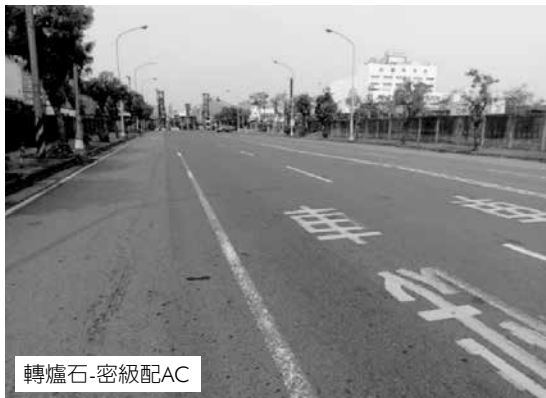
圖六 高雄市亞太路轉爐石粒料與天然粒料瀝青混凝土經過四年之使用狀況圖
