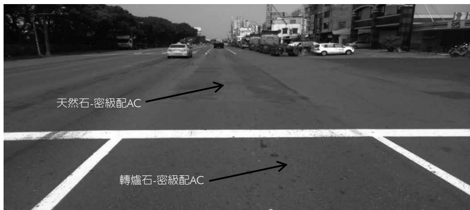
圖七 高雄市大業北路轉爐石粒料及天然石粒料應用於密級配之比較圖
