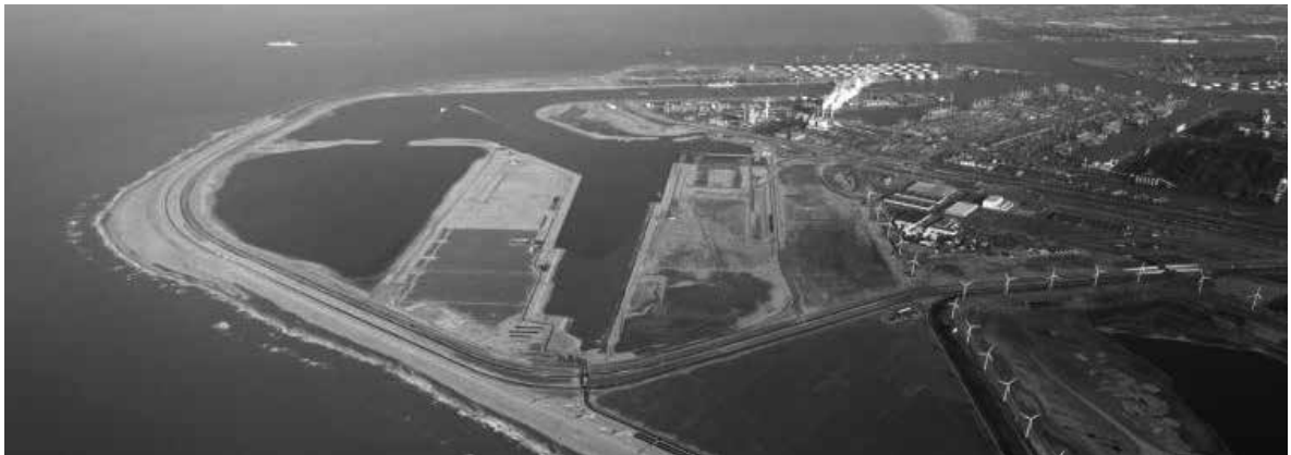
圖12 荷蘭Yangtze port填海造陸工程
