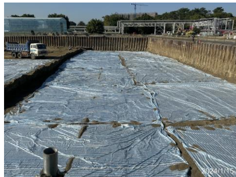
不透水帆布覆蓋開挖坑
