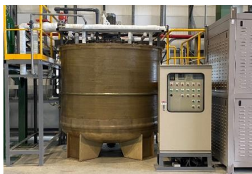
圖 4、實廠固態氯化銨結晶設備
